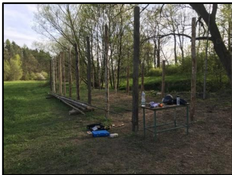
Základy kuchyně a jídelny
